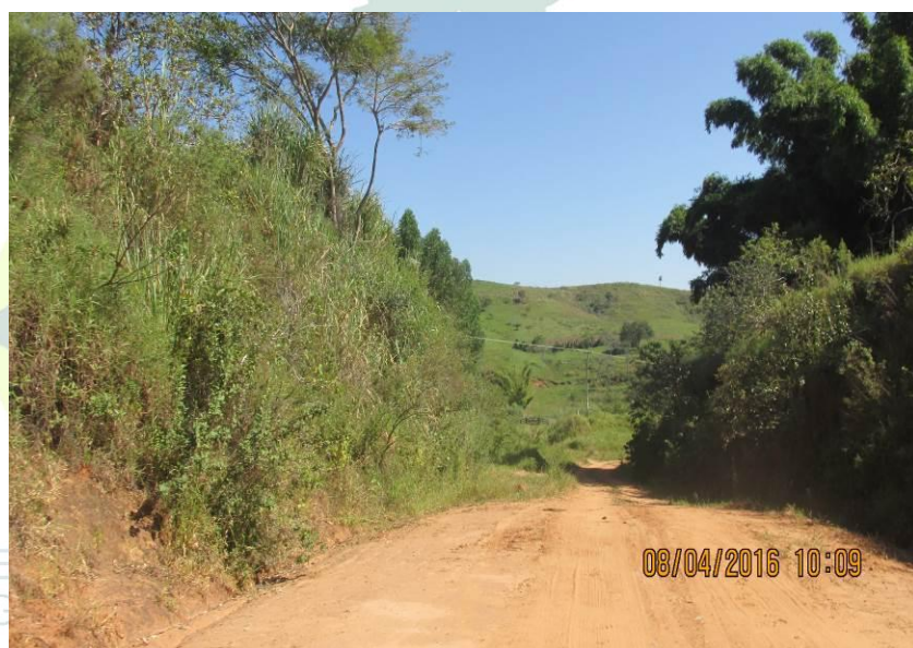
Figura 101 - Trecho encaixado entre barrancos.
