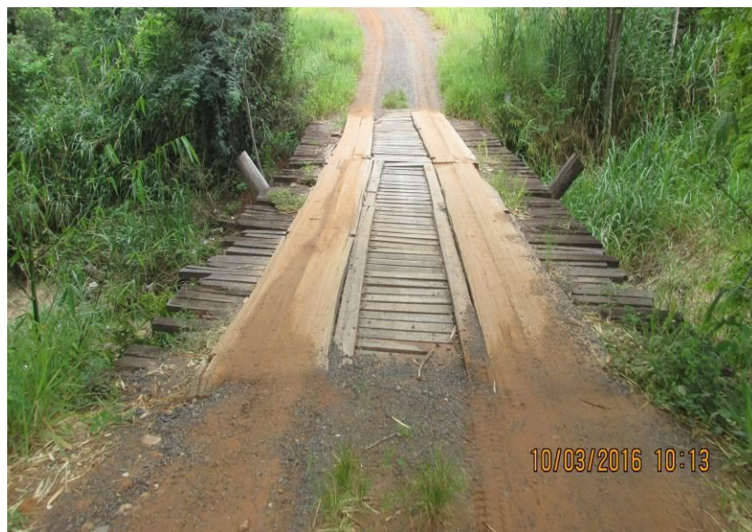
Figura 269 - Ponte de madeira com 23,40 x 4,70 x 3,60 metros.
