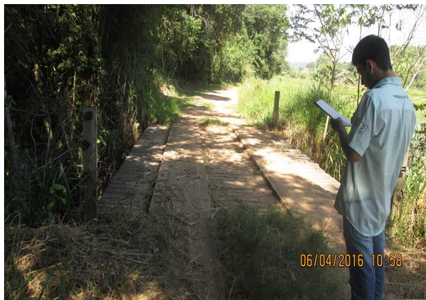
Figura 284 - Ponte de madeira medindo 22,50 x 4,30 x 2,70 metros.
