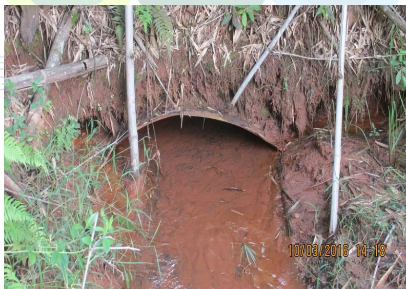
Figura 320 - Tubulação de concreto de 1000 mm.
