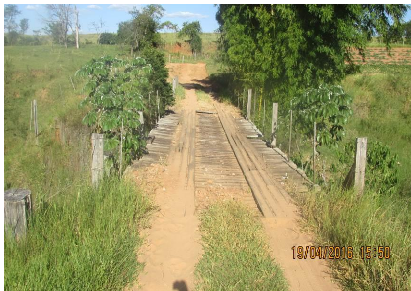
Figura 124 - Ponte de madeira com dimensões de 17,30 x 4,20 x 5,40 metros.
