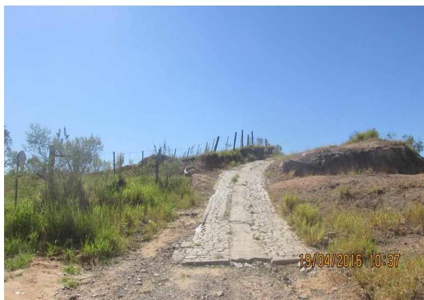
Figura 141 - Revestimento com paralelepípedo.
