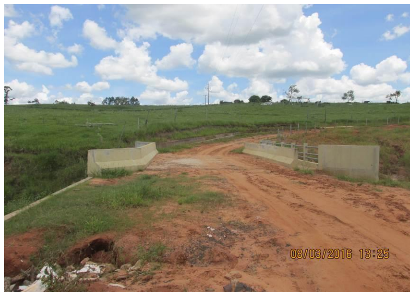
Figura 346 - Ponte de alvenaria medindo 11,40 x 8,30 x 6,60 metros.
