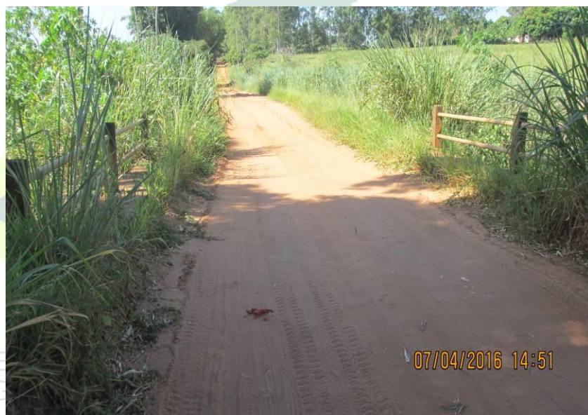
Figura 113 - Ponte de alvenaria de 7,40 x 6,00 x 2,70 metros.
