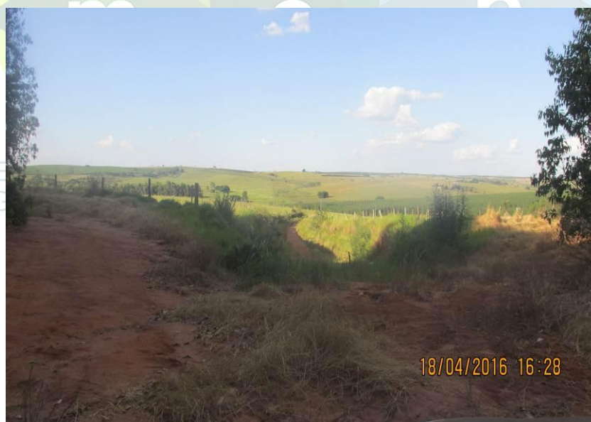
Figura 152 - Interdição da estrada por más condições.
