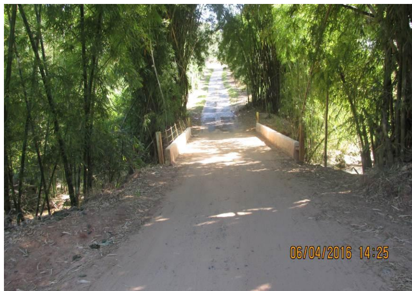
Figura 291 - Ponte de alvenaria com medidas de 11,60 x 4,60 x 2,90 metros.
