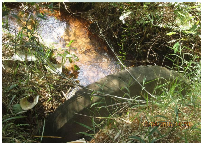
Figura 50 - Tubulação de concreto de 1500 mm.
