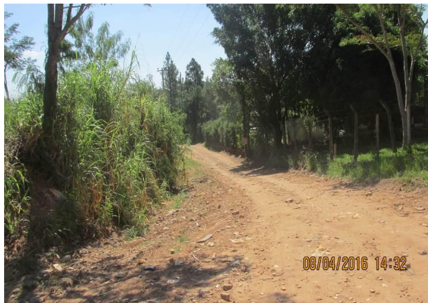
Figura 90 - Plataforma não conformada.
