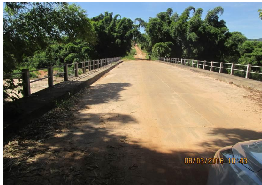
Figura 336 - Ponte de alvenaria medindo 63,50 x 10,40 x 11,50 metros.
