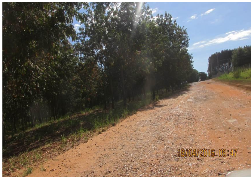
Figura 179 - Revestimento de cascalho.
