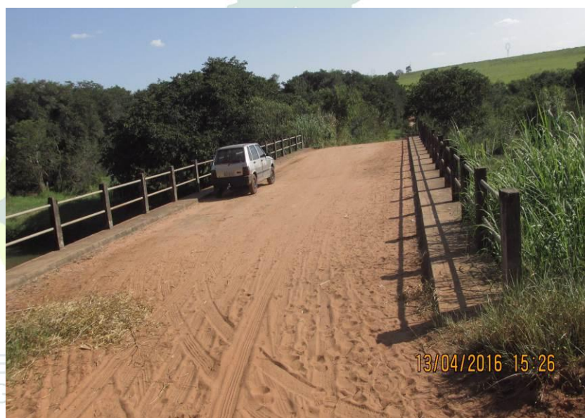
Figura 246 - Ponte de alvenaria com dimensões de 32,70 x 9,30 x 8,00 metros.
