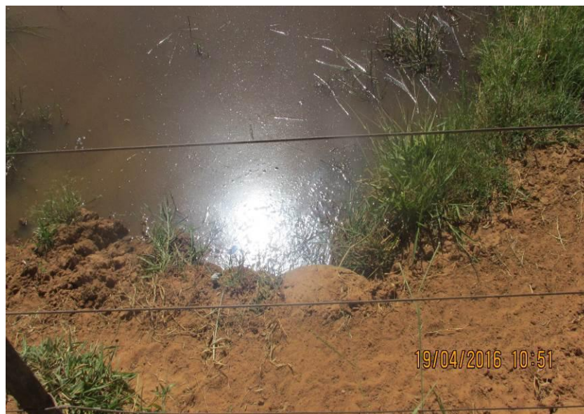
Figura 137 - Tubulação de concreto de 600 mm.
