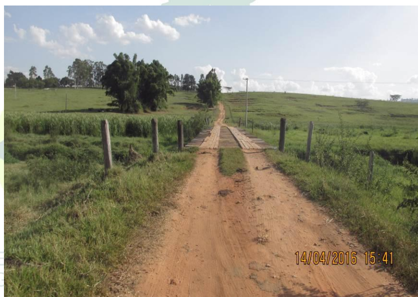
Figura 214 - Ponte de madeira com 34,00 x 4,40 x 5,40.
