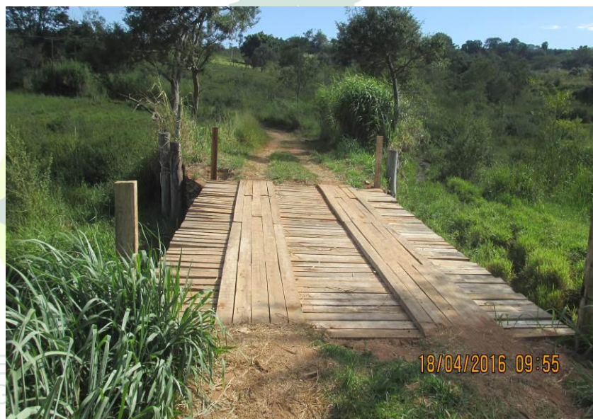
Figura 182 - Ponte de madeira de 10,00 x 4,20 x 3,40 metros.
