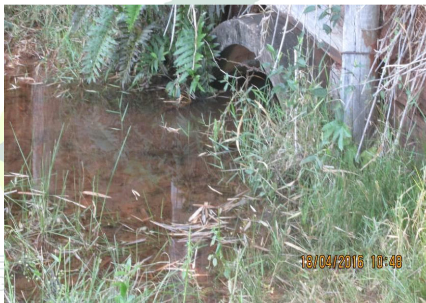
Figura 175 - Tubulação de concreto de 1000 mm.
