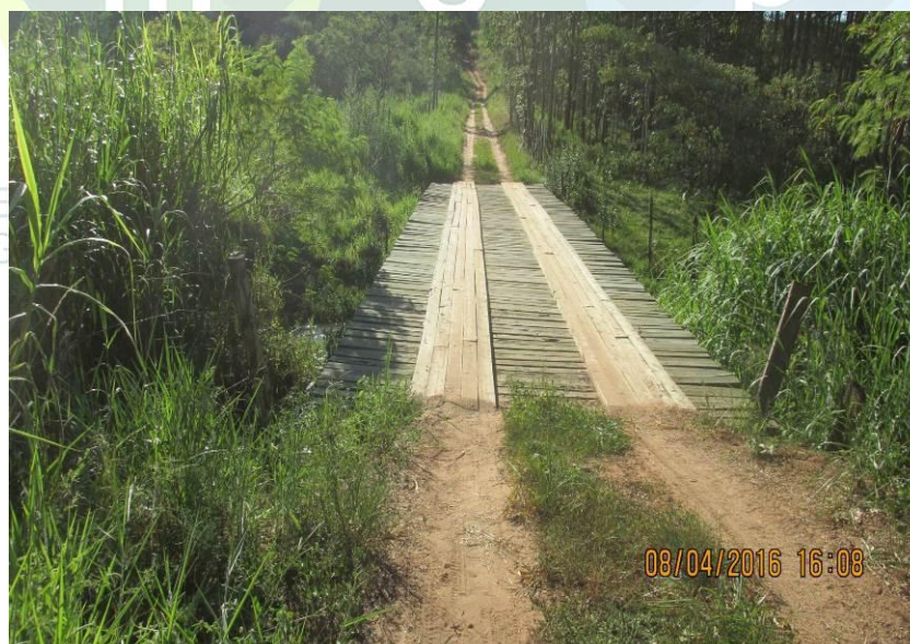
Figura 73 - Ponte de madeira de 22,40 x 4,40 x 3,10 metros.
