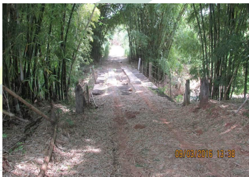
Figura 272 - Ponte de madeira medindo 14,80 x 4,30 x 5,20 metros.
