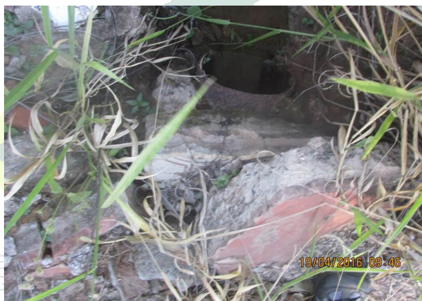
Figura 148 - Tubulação de ferro de 100 mm.
