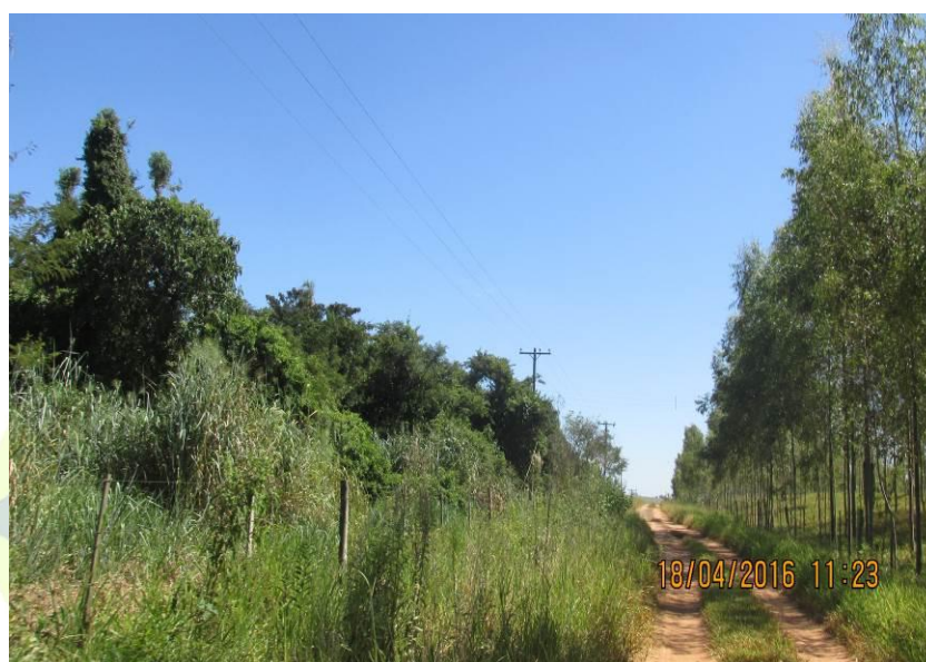
Figura 171 - Ausência de saída d'água.
