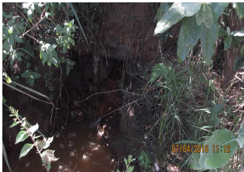
Figura 311 - Tubulação de concreto de 800mm.
