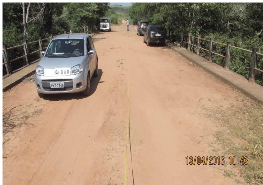
Figura 61 - Ponte de concreto de 73,00 x 10,00 x 9,50 metros.
