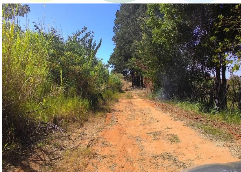
Figura 347 - Ausência de saída d'água.
