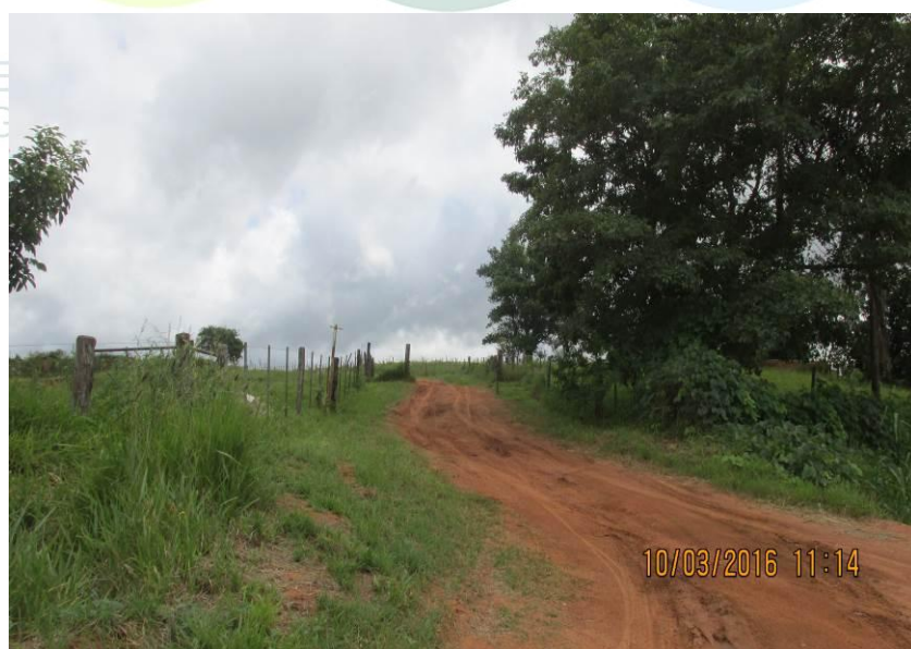
Figura 285 - Ausência de saída d'água.
