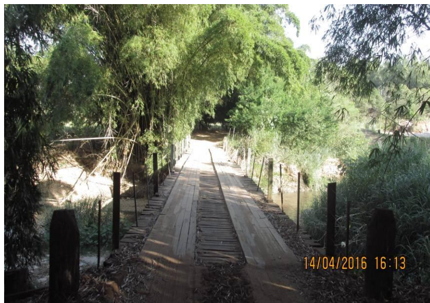
Figura 206 - Ponte de madeira medindo 38,00 x 4,10 x 4,80 metros.
