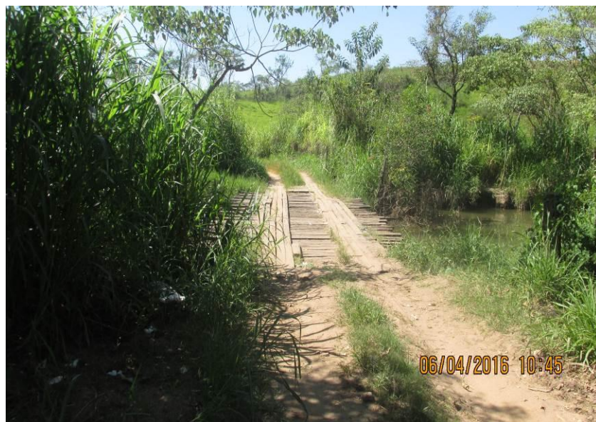
Figura 282 - Ponte de madeira com 16,70 x 4,60 x 4,00 metros.
