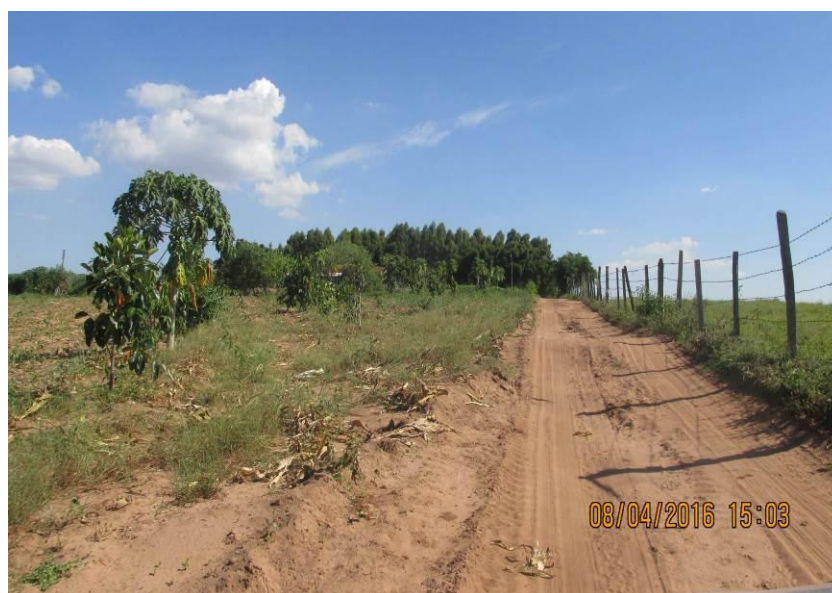
Figura 88 - Ausência de saída d'água.
