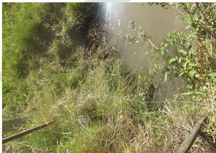
Figura 130 - Tubulação de concreto de 600mm.
