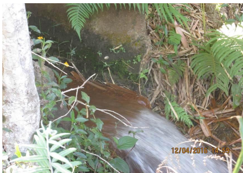
Figura 53 - Tubulação de concreto de 1500 mm.
