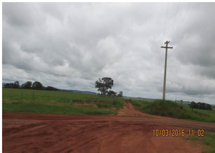
Figura 288 - Final da estrada.
