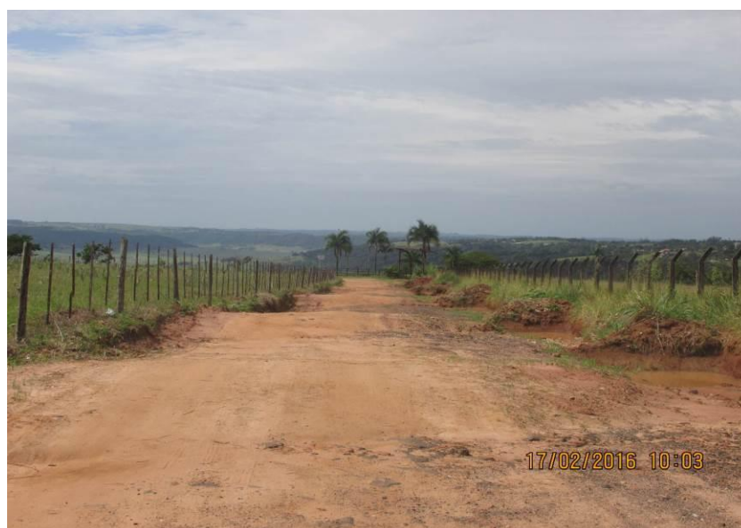
Figura 25 - Caixas de contenção na lateral da estrada.
