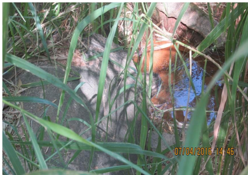
Figura 102 - Tubulação de concreto de 1500 mm.
