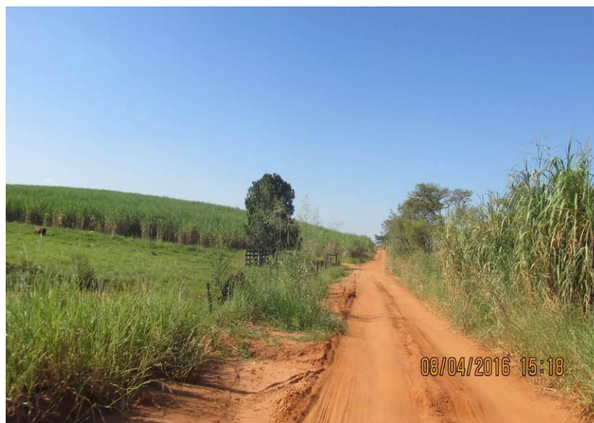
Figura 84 - Plataforma não conformada.
