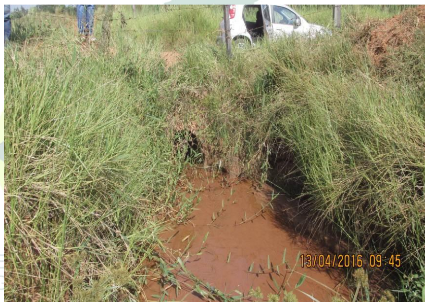
Figura 238 - Tubulação de concreto de 600 mm.
