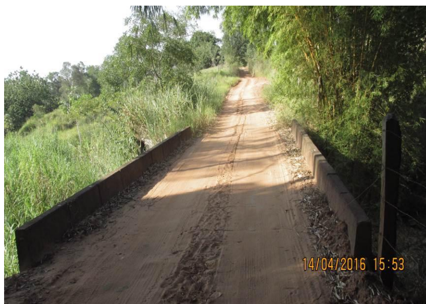
Figura 215 - Ponte de alvenaria medindo 11,20 x 4,40 x 2,60 metros.
