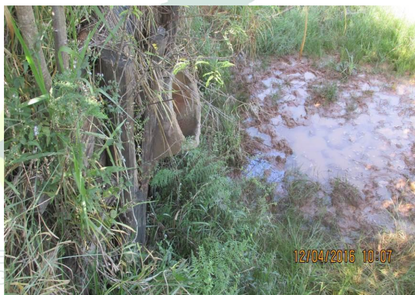
Figura 69 - Tubulação de concreto de 1000 mm.
