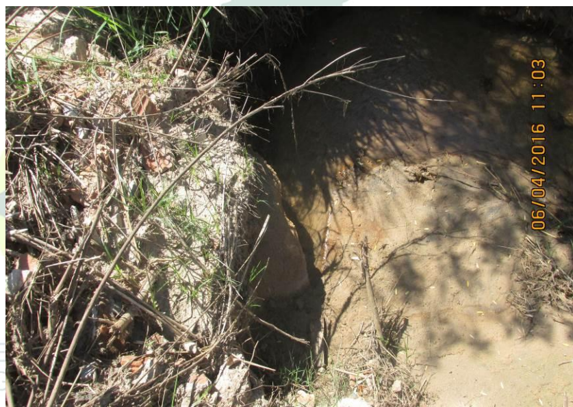
Figura 283 - Tubulação de concreto de 600 mm.
