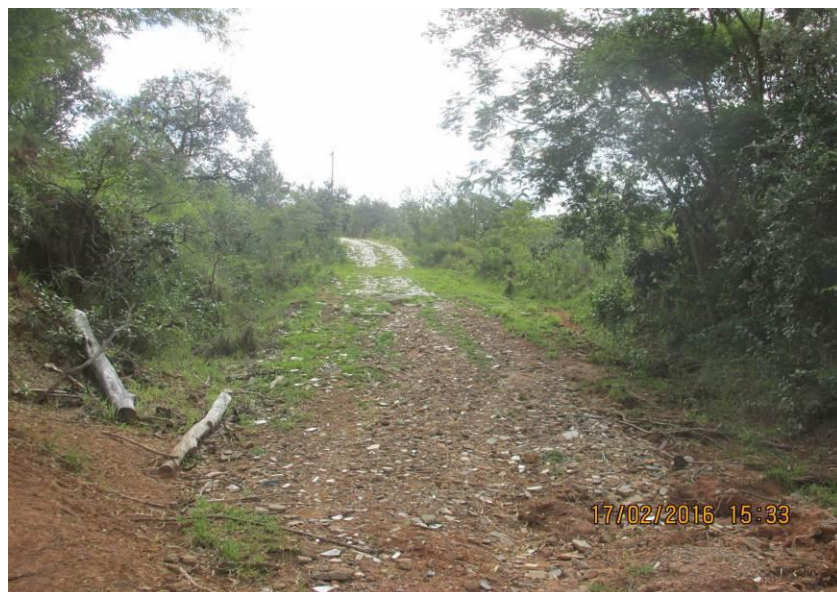
Figura 45 - Início de trecho com paralelepípedo.
