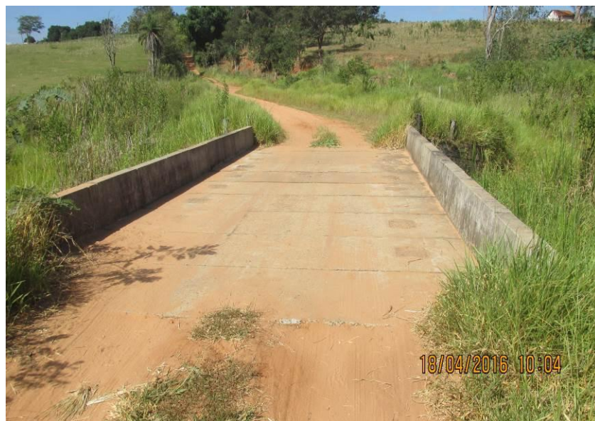
Figura 181 - Ponte de alvenaria de 8,20 x 4,40 x 3,20 metros.
