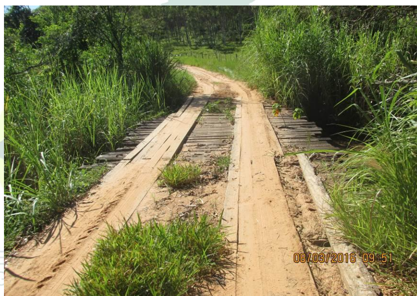
Figura 340 - Ponte de madeira com 12,20 x 4,20 x 1,40 metros.
