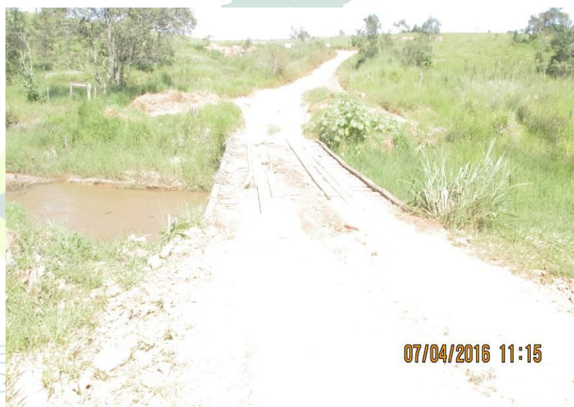
Figura 312 - Ponte de madeira com 15,90 x 4,20 x 2,10 metros.
