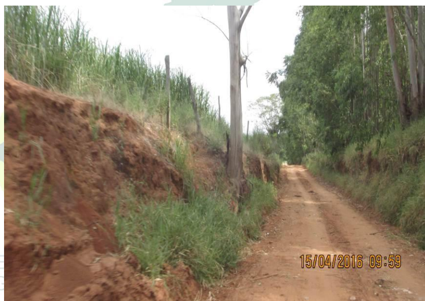
Figura 201 - Trecho encaixado entre barrancos.
