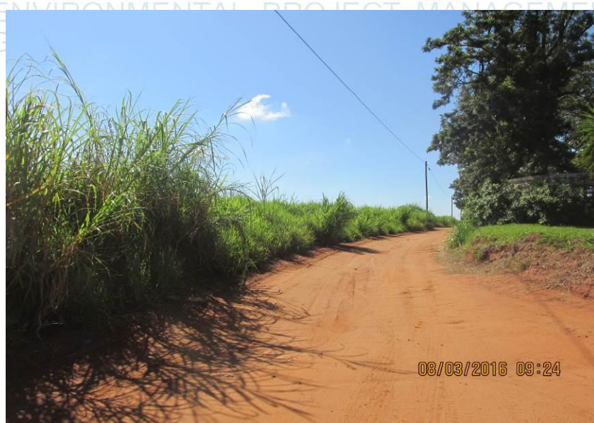
Figura 337 - Ausência de revestimento.
