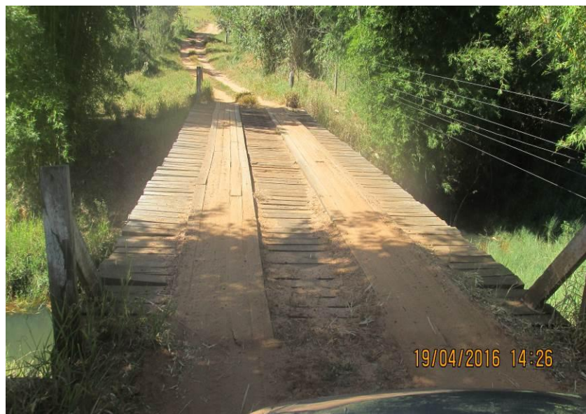
Figura 131 - Ponte de madeira de 16,00 x 4,40 x 4,60 metros.
