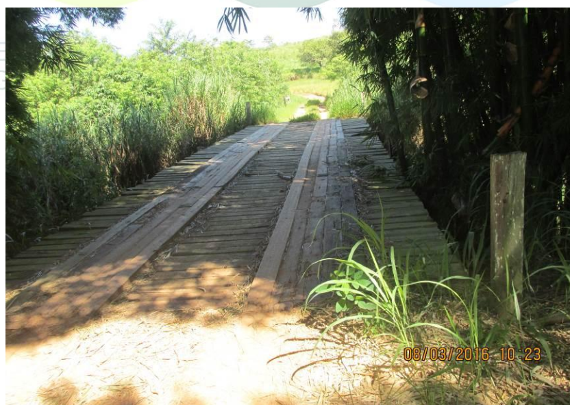
Figura 344 - Ponte de madeira de 15,50 x 4,20 x 5,00 metros.
