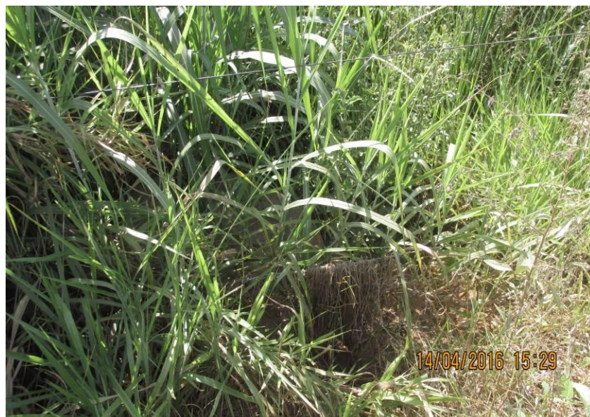
Figura 211 - Tubulação de 1000 mm de concreto.
