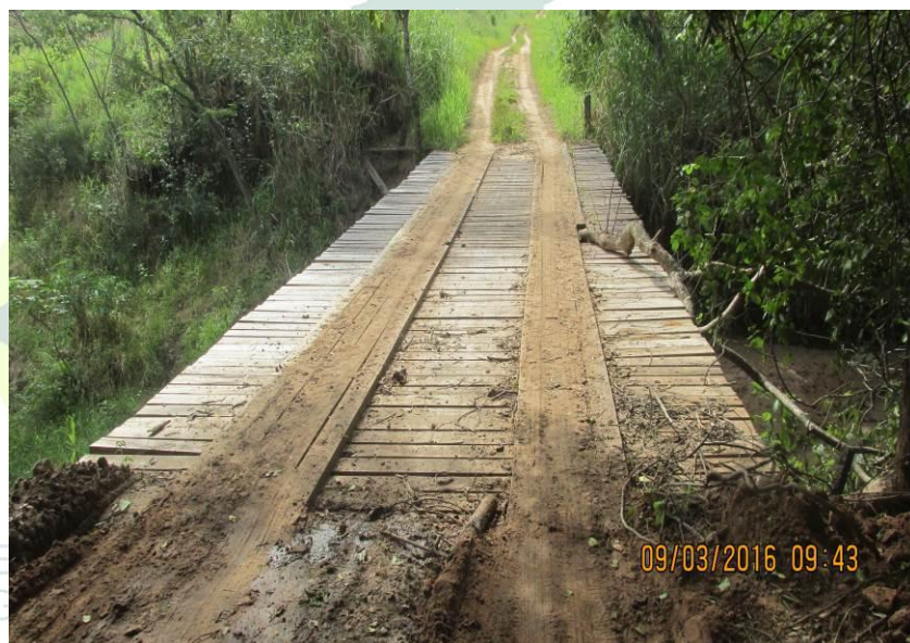
Figura 327 - Ponte de madeira 16,40 x 4,00 x 4,20 metros.
