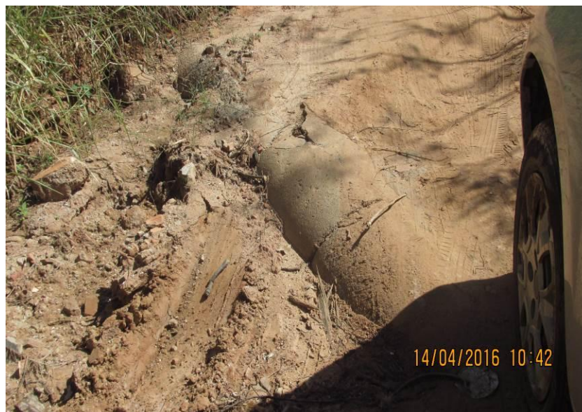
Figura 229 - Tubulação de concreto de 800 mm.
