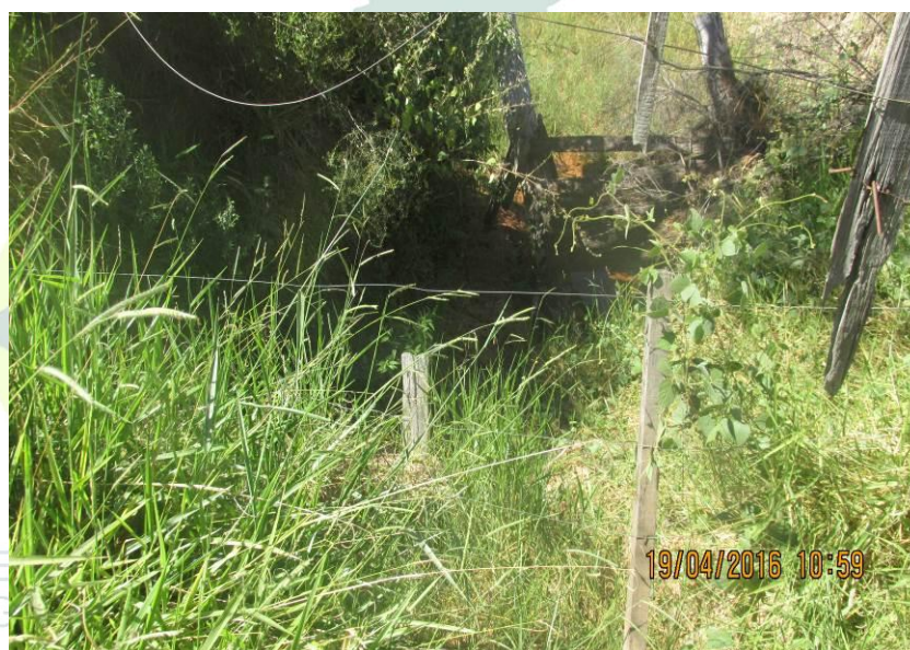
Figura 138 - Tubo de 1500 mm de concreto.
