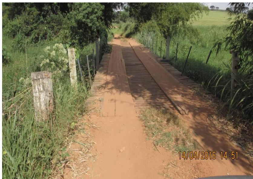
Figura 224 - Ponte de madeira com 20,20 x 4,10 x 4,00 metros.
