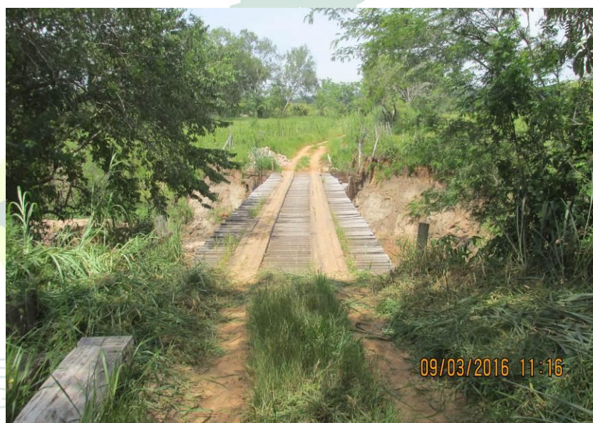
Figura 352 - Ponte de madeira com 27 x 4,30 x 3,70 metros.
