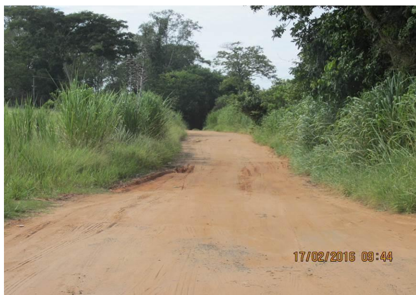
Figura 21 - Passagem d'água sob a estrada.
