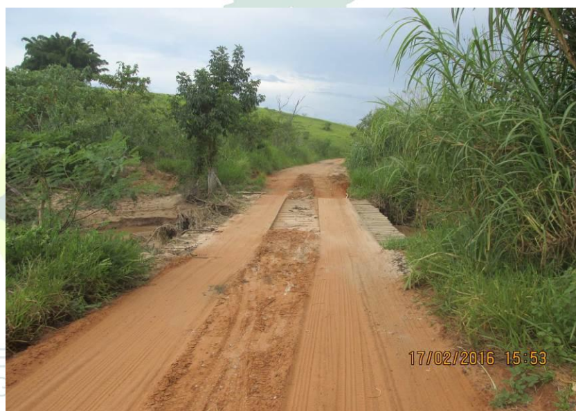
Figura 48 - Ponte de madeira com as seguintes dimensões 8,00 x 4,10 x 0,80 metros.
