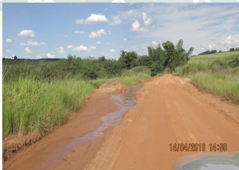
Figura 219 - Afloramento do lençol freático.
