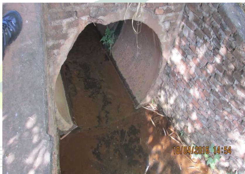
Figura 166 - Tubulação de 1000 mm de concreto.
