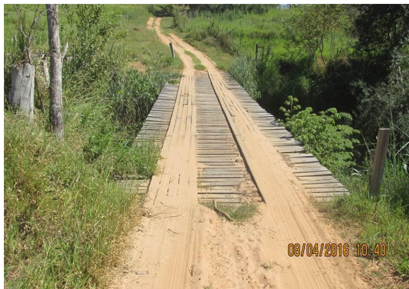
Figura 112 - Ponte de madeira medindo 21,20 x 4,30 x 5,20 metros.
