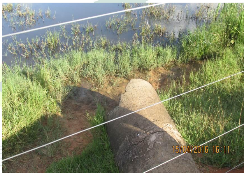
Figura 188 - Tubulação de concreto de 800 mm.
