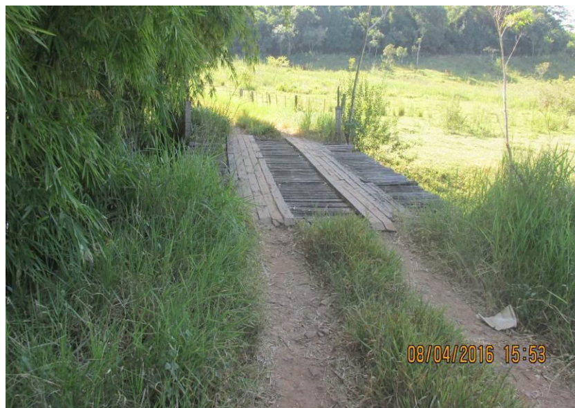
Figura 77 - Ponte de madeira de 7,40 x 4,80 x 2,50 metros.
