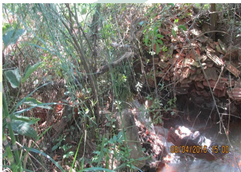
Figura 89 - Tubulação de concreto de 800 mm.
