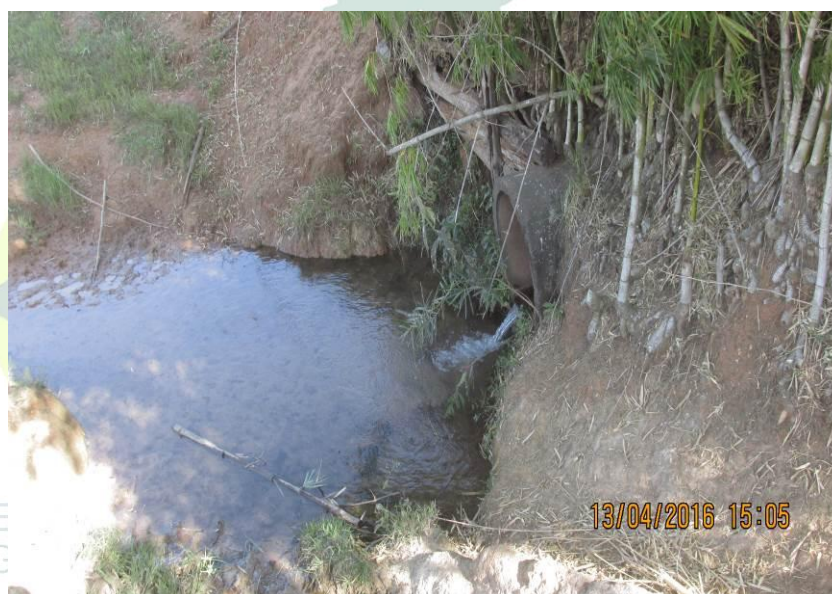
Figura 250 - Duas tubulações de concreto de 1000 mm.
