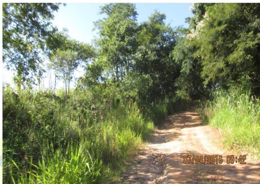
Figura 309 - Processo erosivo no leito carroçável.
