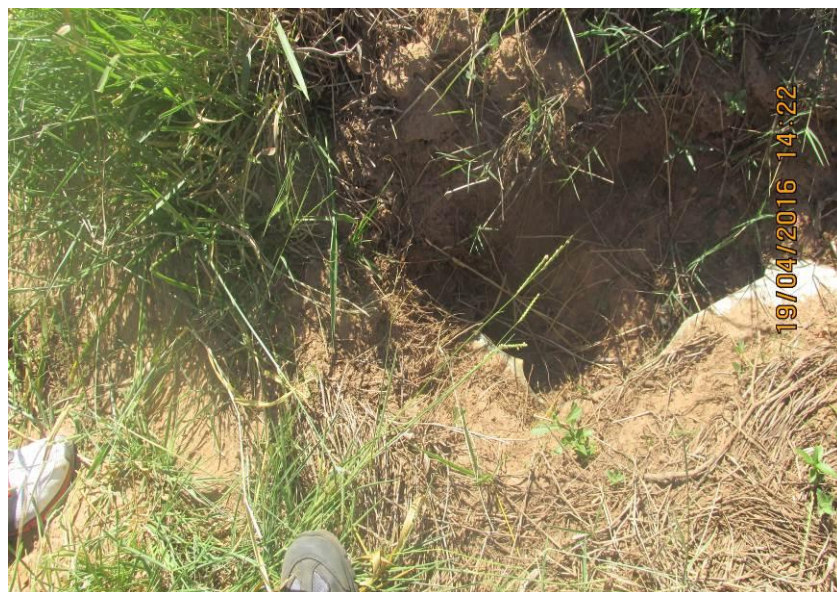
Figura 129 - Tubulação de concreto de 600mm.
