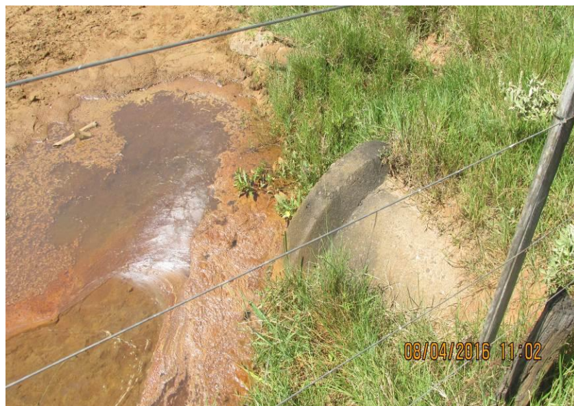
Figura 95 - Tubulação de 1000 mm.
