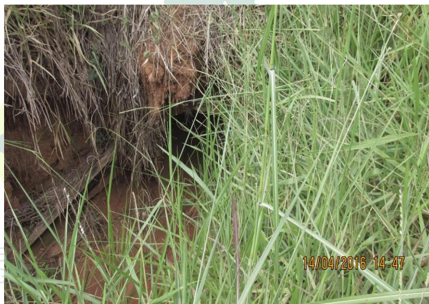
Figura 223 - Tubulação de 800 mm de concreto.
