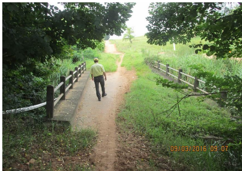
Figura 324 - Ponte de alvenaria medindo 12,60 x 5,80 x 6,10 metros.
