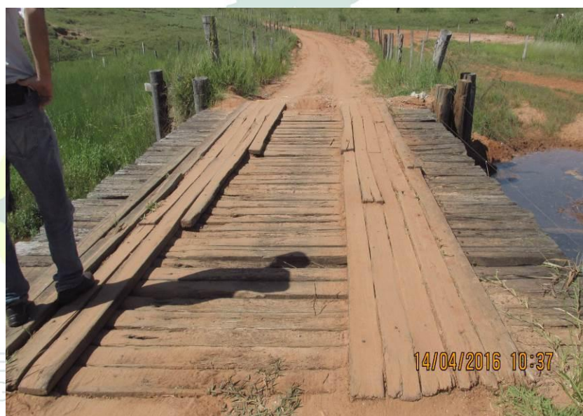
Figura 230 - Ponte de madeira com 8,00 x 4,60 x 4,20 metros.
