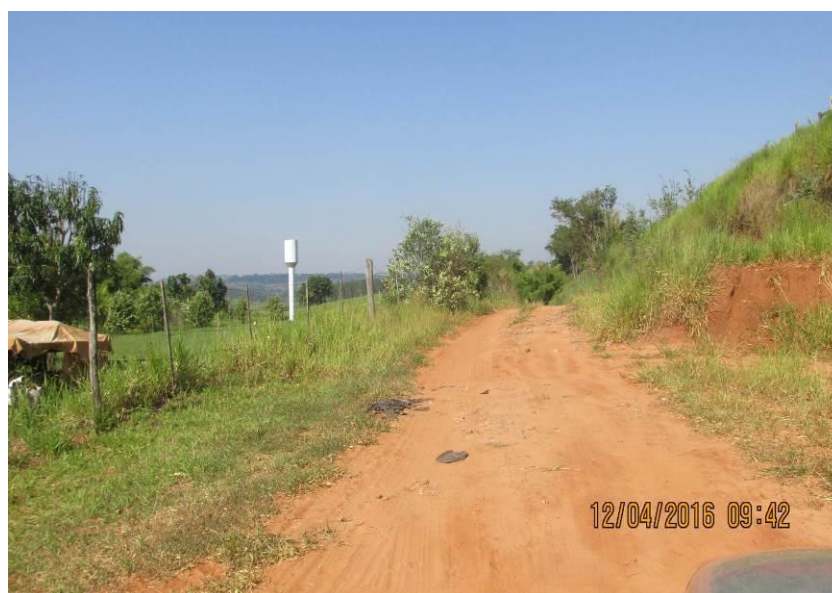
Figura 70 - Plataforma não conformada.
