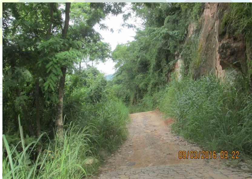
Figura 321 - Trecho de serra revestido com paralelepípedo.
