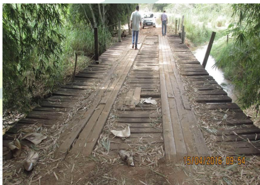
Figura 199 - Ponte de madeira com 19,00 x 4,40 x 2,30 metros.
