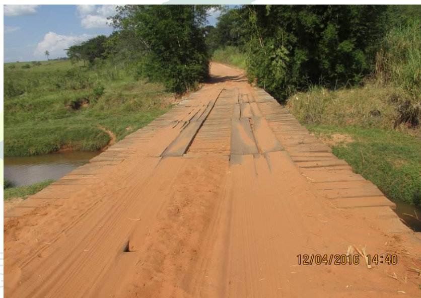
Figura 254 - Ponte de madeira medindo 29,00 x 5,00 x 5,00 metros.
