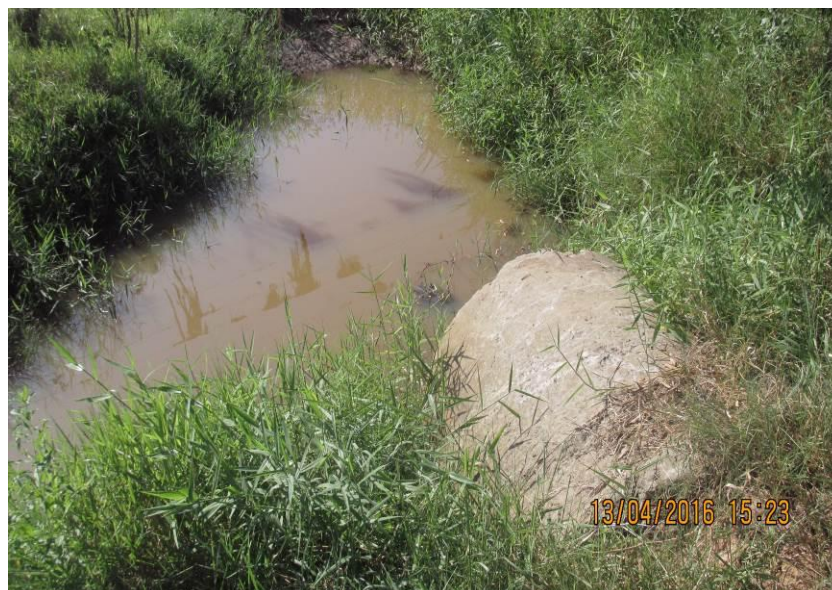
Figura 245 - Tubulação de concreto de 1000 mm.
