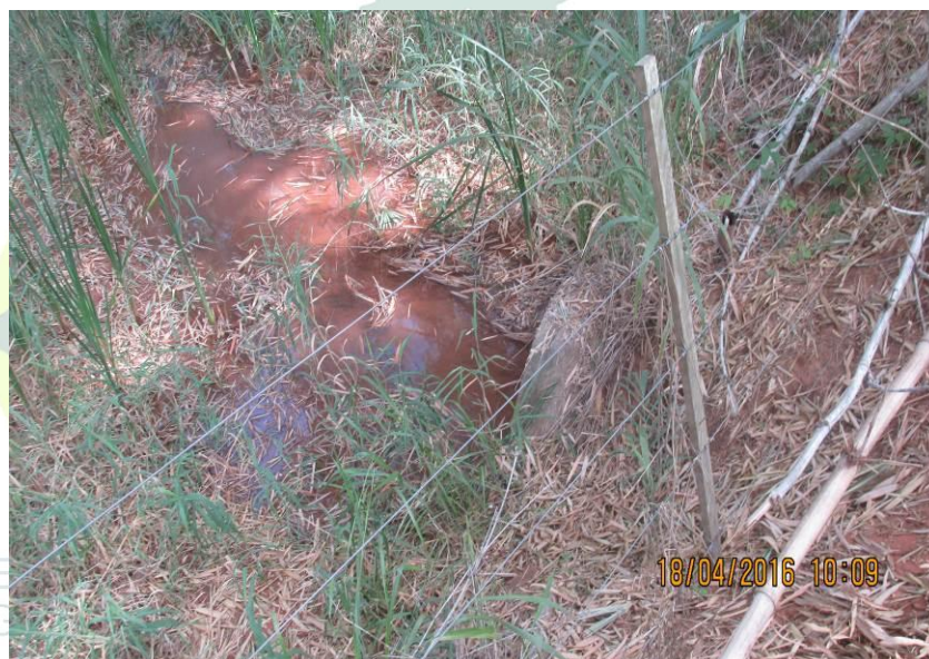
Figura 180 - Tubulação de 1500 mm de concreto.
