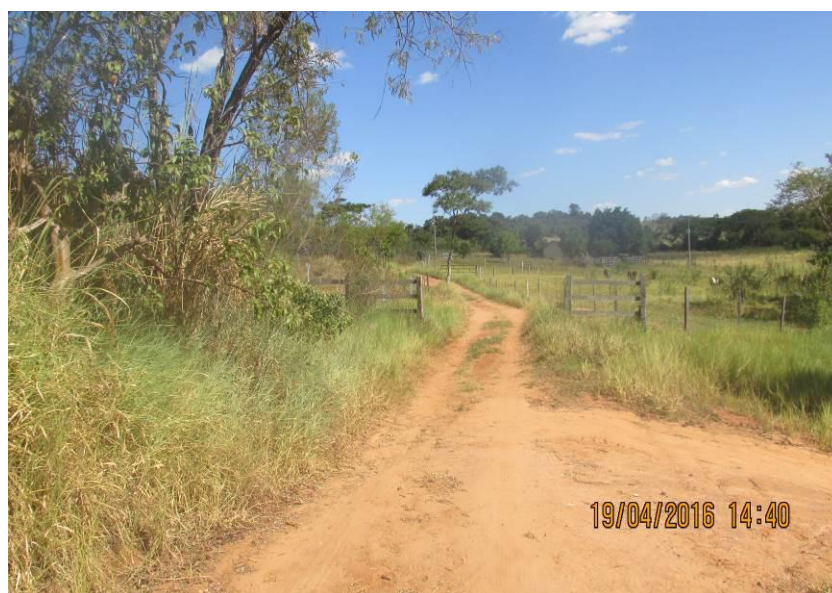
Figura 133 - Ausência de revestimento.
