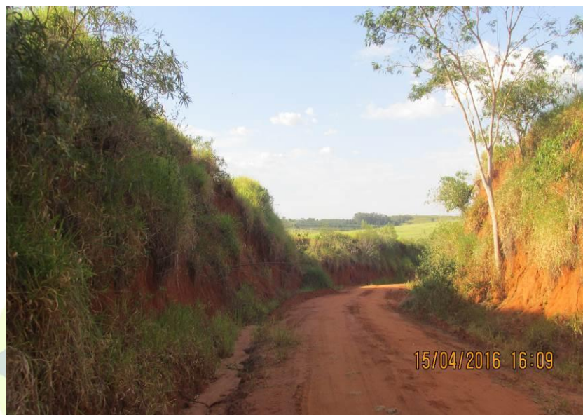
Figura 185 - Trecho encaixado entre barrancos.
