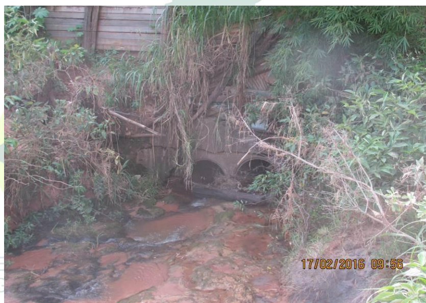
Figura 24 - Duas tubulações de concreto de 800 mm.
