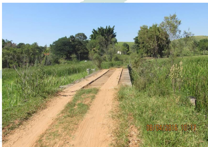
Figura 111 - Ponte de madeira de 18,60 x 4,40 x 2,50 metros.
