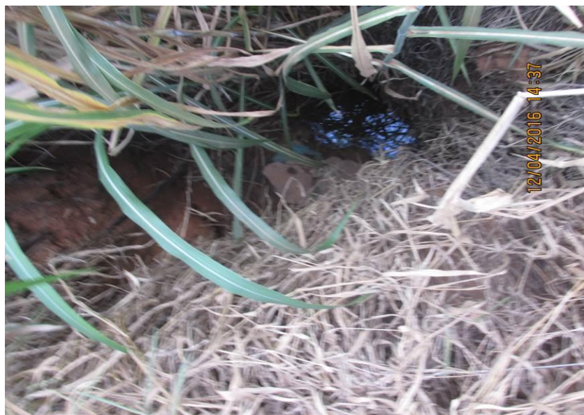
Figura 253 - Tubulação de concreto afogada.
