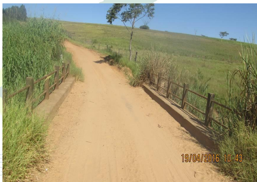
Figura 142 - Ponte de alvenaria com 11,20 x 6,00 x 4,20 metros.
