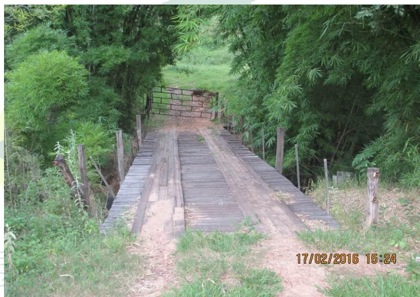
Figura 46 - Ponte de madeira, dimensões 20,40 x 4,60 x 5,60 metros.
