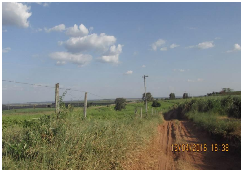
Figura 232 - Ausência de saída d'água.
