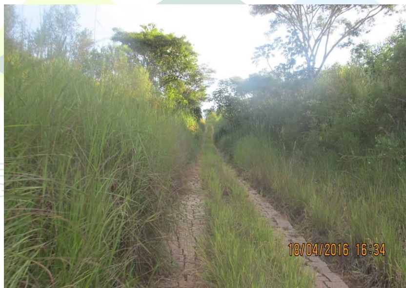
Figura 150 - Trecho revestido com paralelepípedo e gramíneas no leito carroçável.
