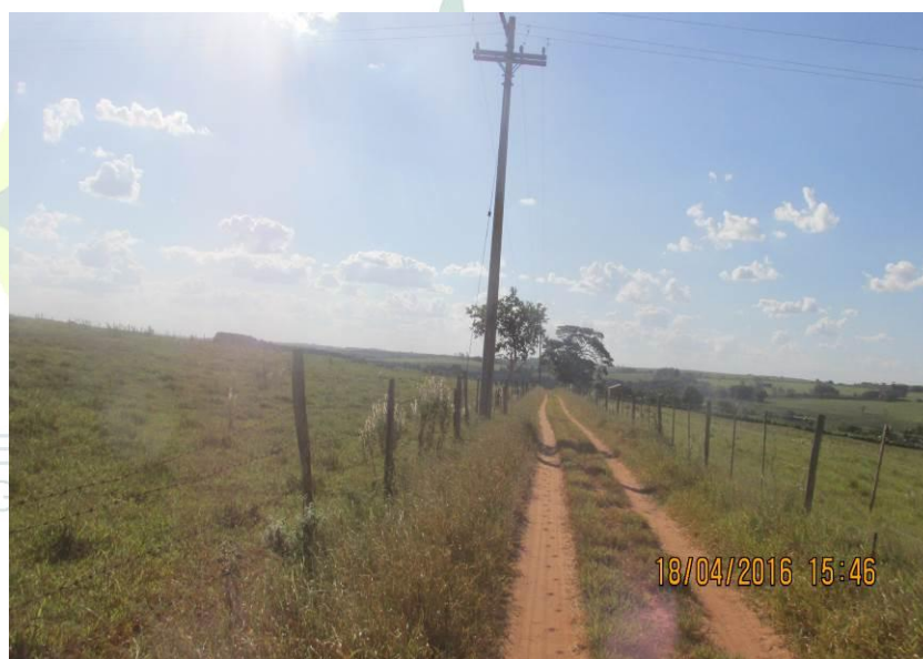
Figura 155 - Ausência de saída d'água.
