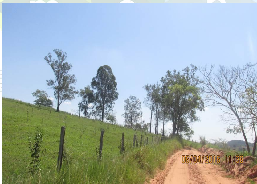
Figura 300 - Ausência de saída d'água.
