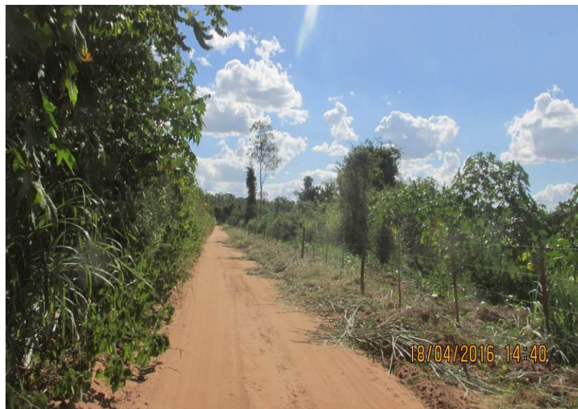
Figura 167 - Ausência de saída d'água.
