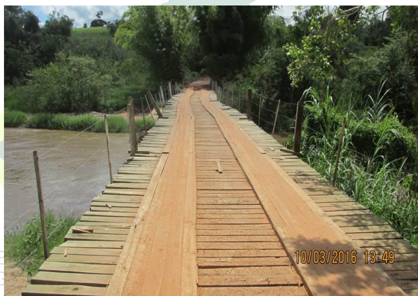
Figura 276 - Ponte de madeira de 54,00 x 4,00 x 3,30 metros.
