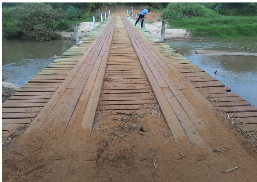
Figura 315 – Ponte de madeira medindo, 49,00 x 4,20 x 4,00 metros.
