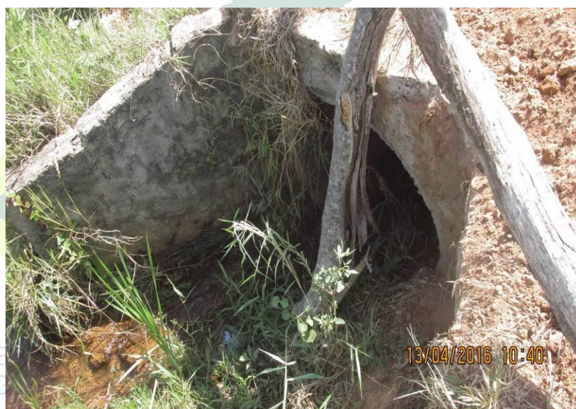
Figura 62 - Tubulação de concreto de 1000 mm.
