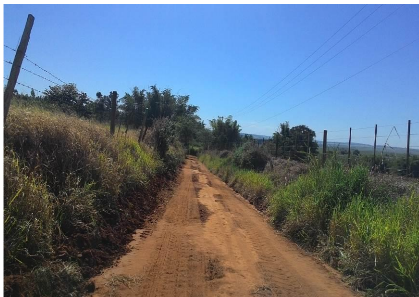
Figura 263 - Ausência de saída d'água.
