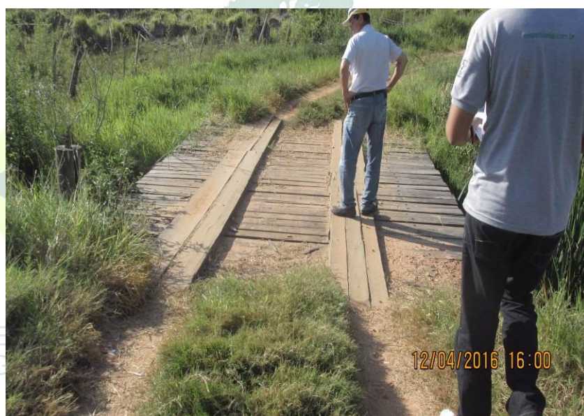
Figura 260 - Ponte de madeira medindo 10,20 x 4,40 x 3,60.
