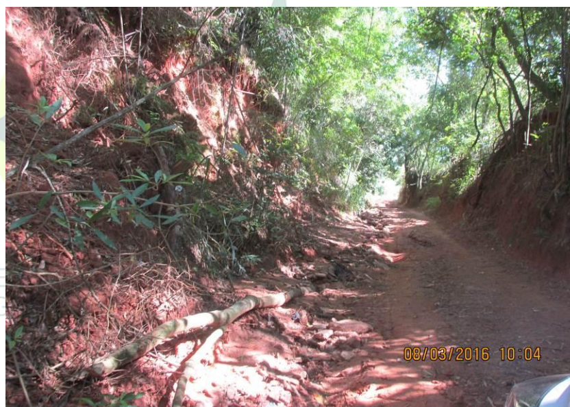
Figura 342 - Trecho encaixado entre barrancos.
