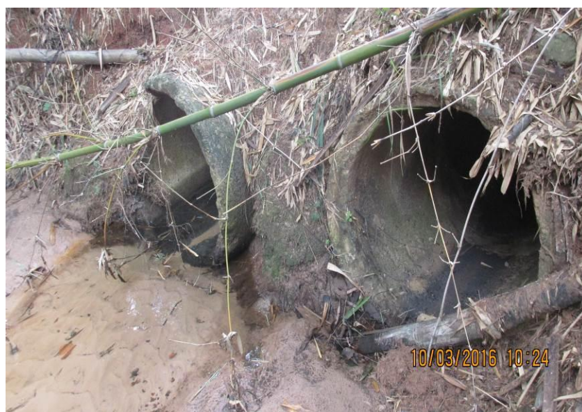
Figura 271 - Duas tubulações de concreto de 800 mm.
