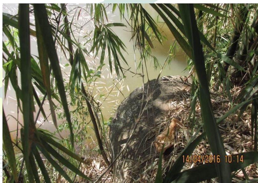
Figura 207 - Tubulação de 1000 mm de concreto.
