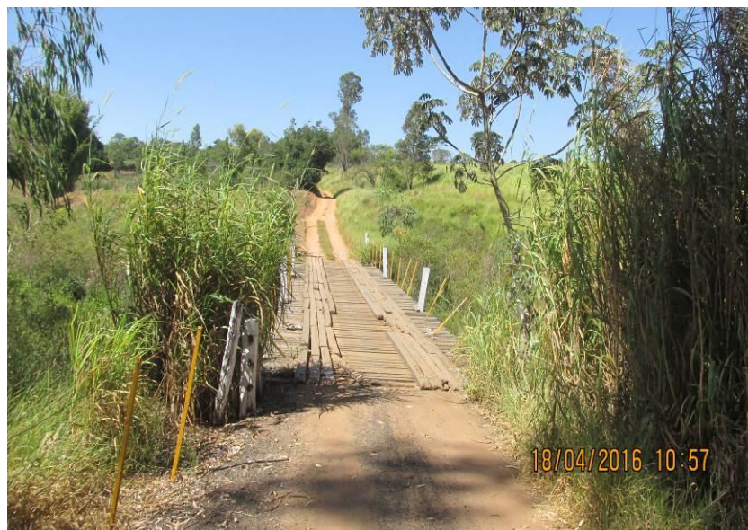
Figura 176 - Ponte de madeira de 23,00 x 4,60 x 4,00 metros.
