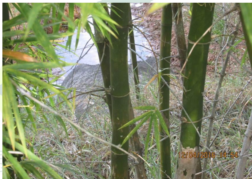
Figura 52 - Tubulação de concreto de 1500 mm.
