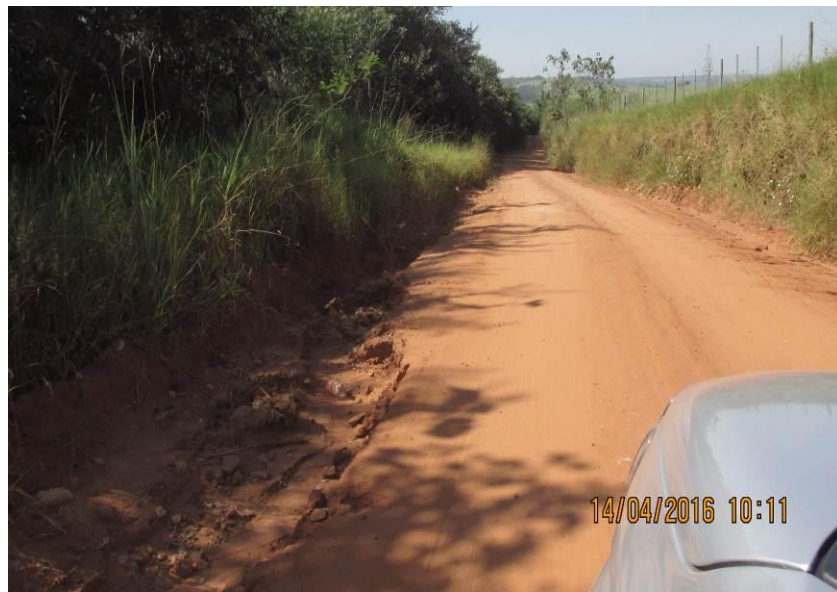
Figura 204 - Processo erosivo na lateral da estrada.
