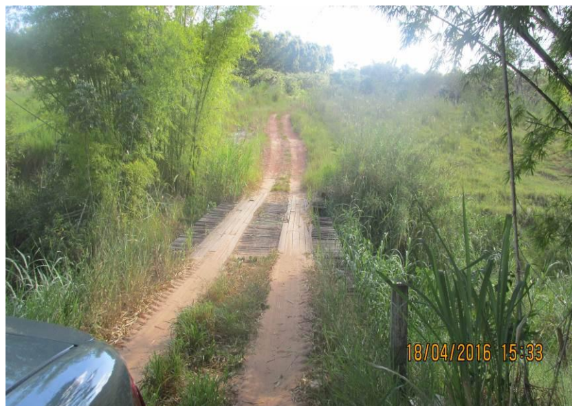
Figura 158 - Ponte de madeira de 19,30 x 4,60 x 5,00 metros.
