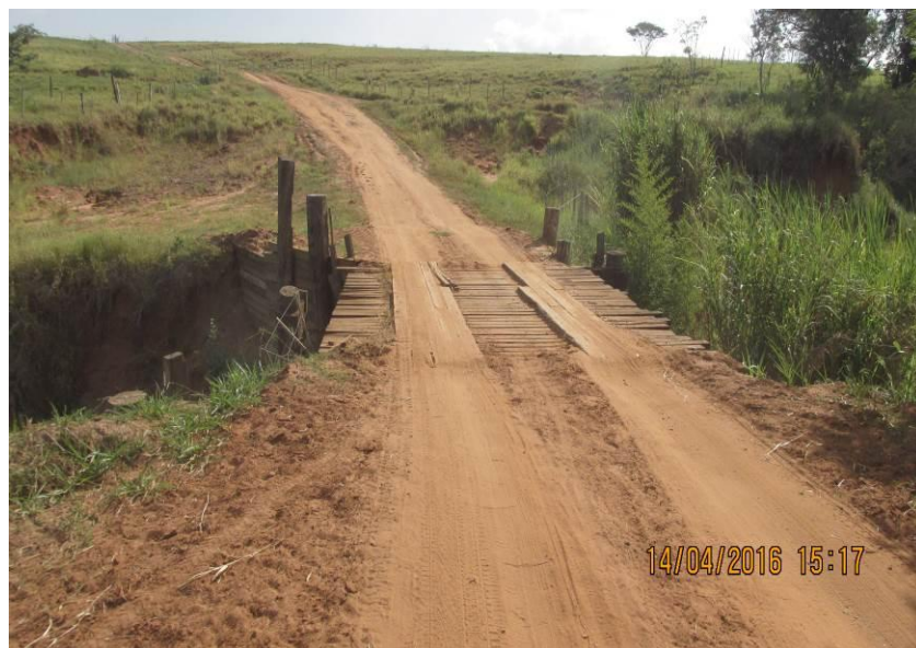
Figura 213 - Ponte de madeira com 7,40 x 4,60 x 4,60 metros.
