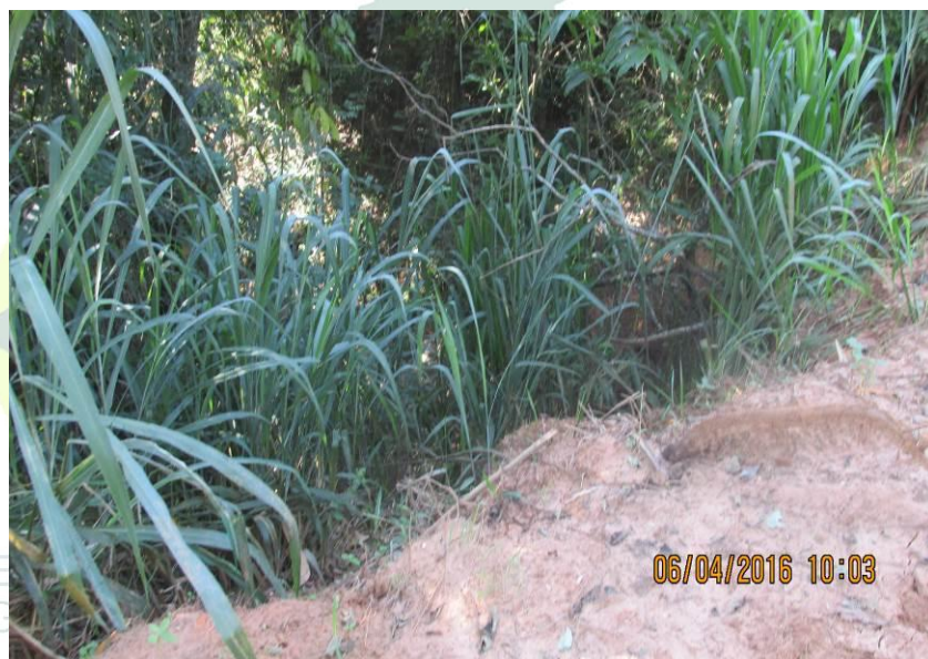
Figura 281 - Tubulação de 600 mm.
