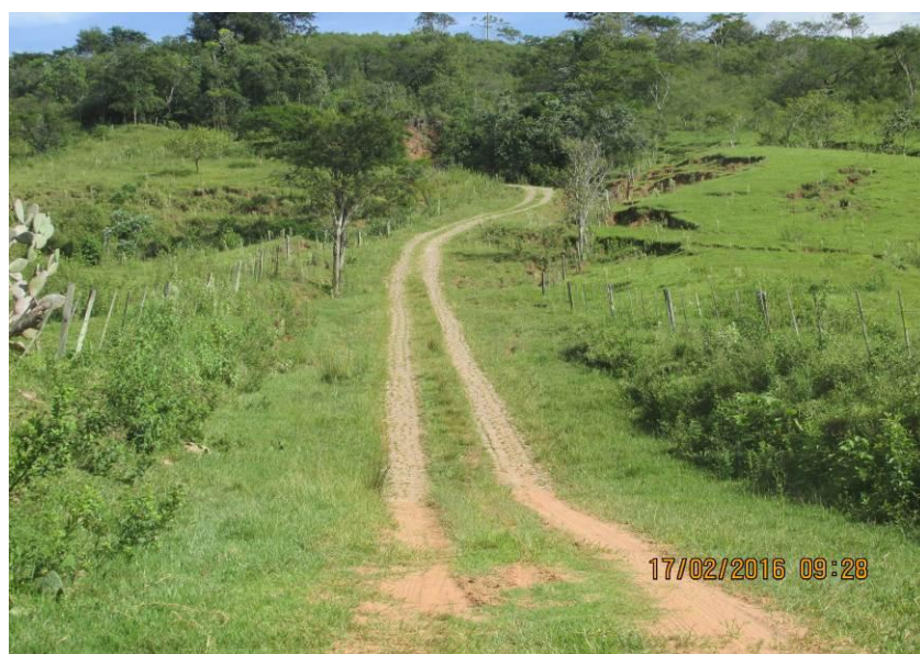
Figura 18 - Trecho com trilho de concreto.
