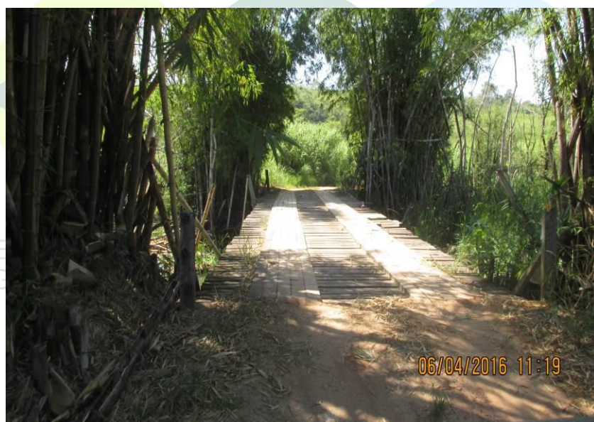
Figura 298 - Ponte de madeira.
