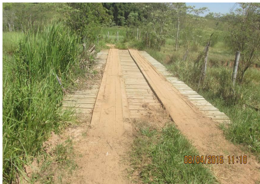
Figura 97 - Ponte de madeira de 17,40 x 4,40 x 3,80 metros.
