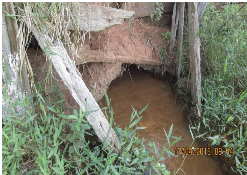
Figura 241 - Tubulação de concreto de 800 mm.
