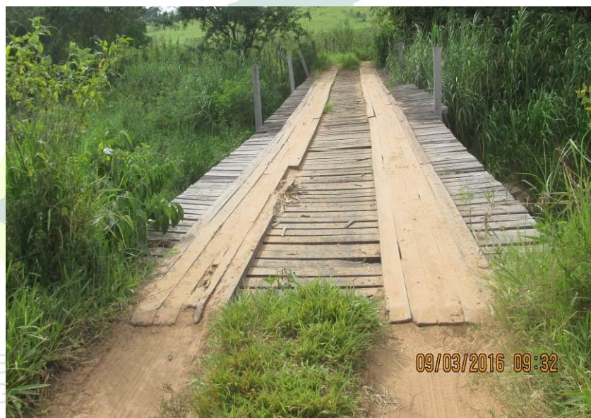
Figura 325 - Ponte de madeira com 24,70 x 4,40 x 3,70 metros.
