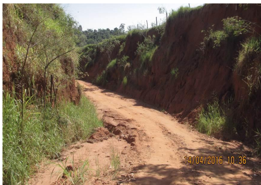
Figura 227 - Trecho encaixado entre barrancos.
