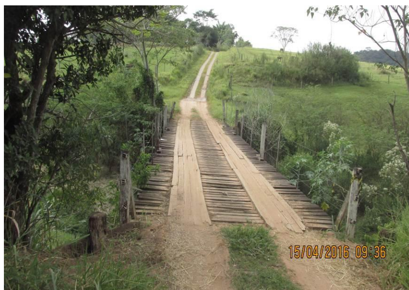
Figura 198 - Ponte de madeira medindo 19,20 x 4,10 x 4,80 metros.
