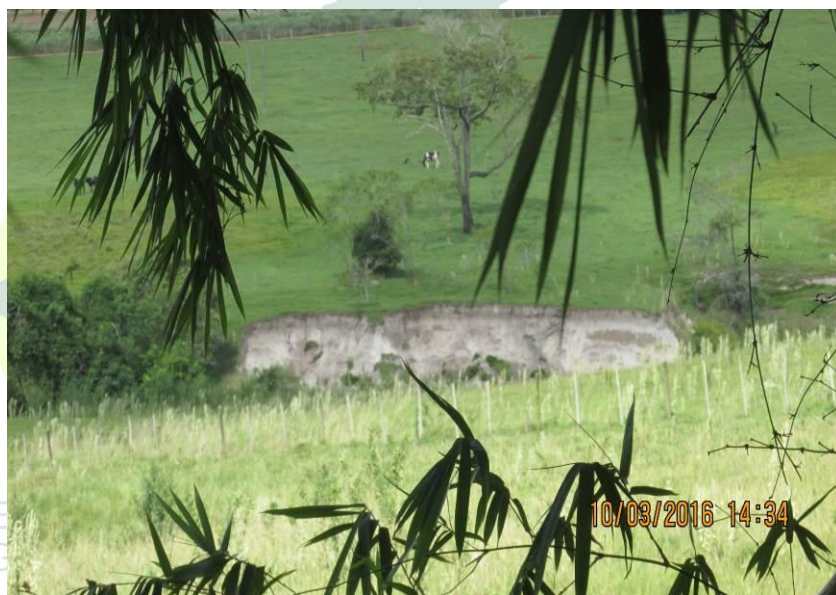
Figura 316 - Voçoroca nas áreas lindeiras.
