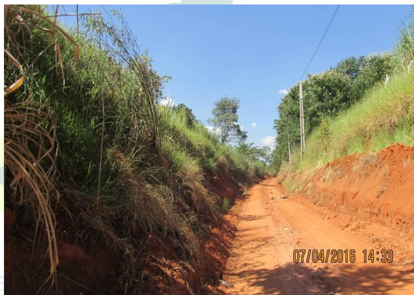
Figura 120 - Trecho encaixado entre barrancos.
