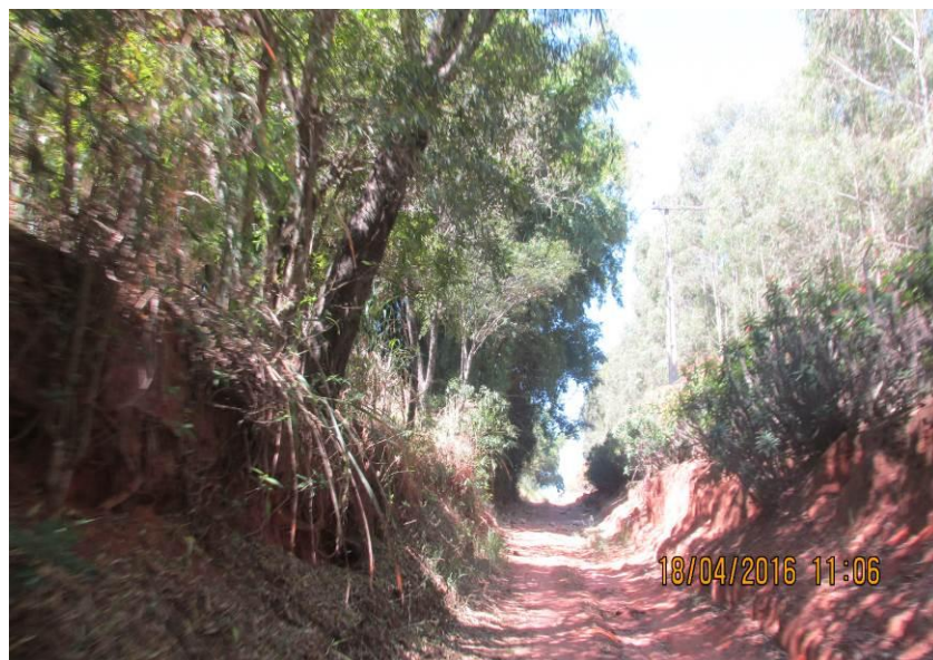
Figura 174 - Trecho encaixado entre barrancos.
