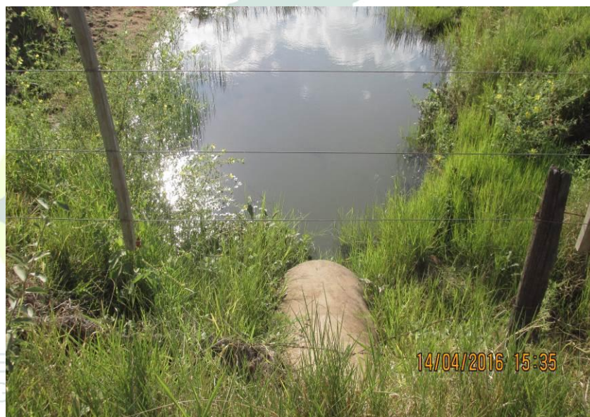
Figura 212 - Duas tubulações de 800 mm de concreto.
