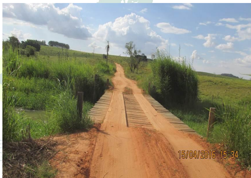
Figura 194 - Ponte de madeira com 14,60 x 4,40 x 2,20 metros.
