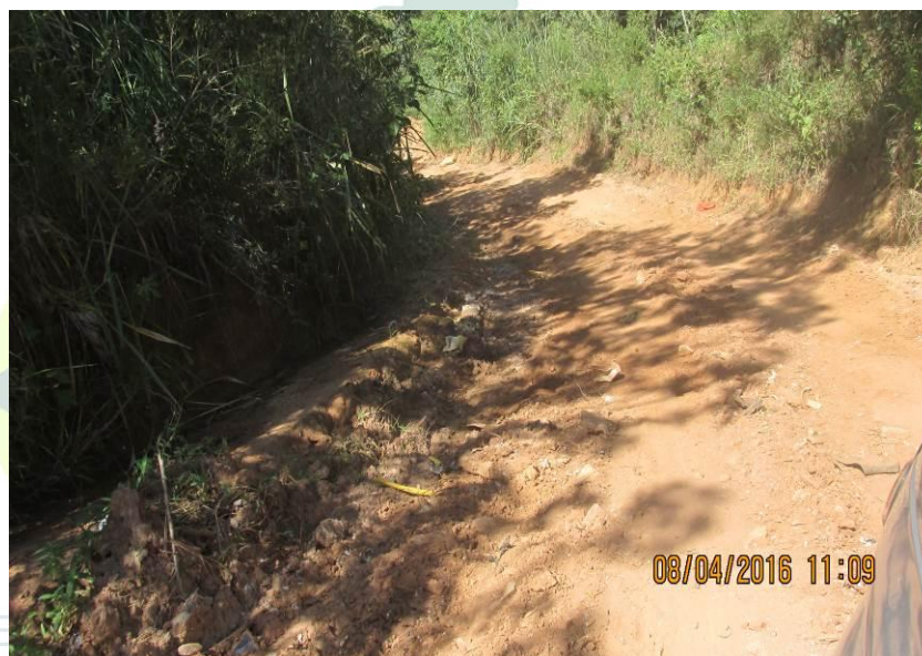
Figura 92 - Processo erosivo na lateral da estrada.
